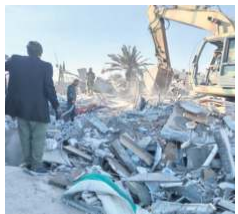
Zerstörung durch Luftangriffe im Irak. Foto: dpa
